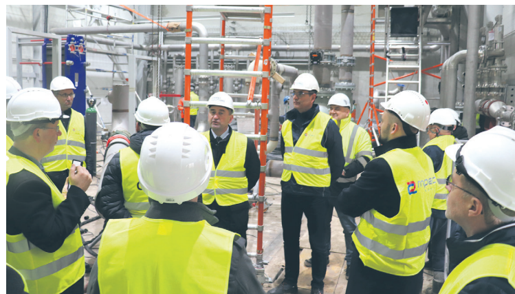
Częścią inwestycji jest budynek ciepłowni, który Islandczycy też mieli okazję zobaczyć
