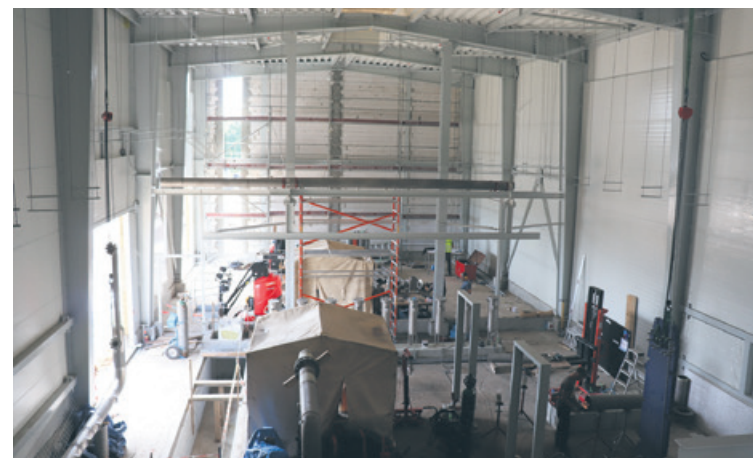
Prace prowadzone są również wewnątrz budynku ciepłowni geotermalnej
