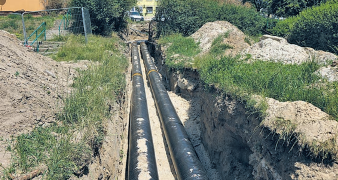
Łączna długość przebudowy i budowy sieci objętej projektem to około 7,5 km, a likwidowanej – około 6,7 km
