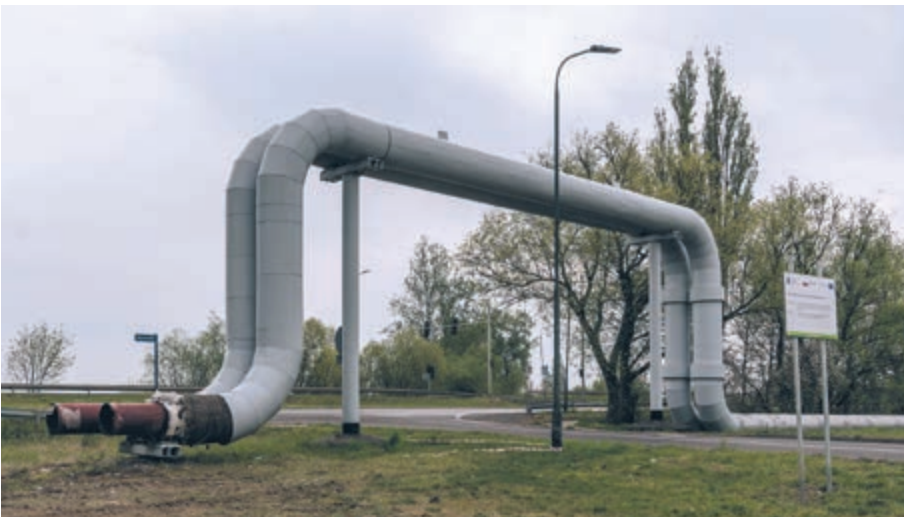
Całe przedsięwzięcie modernizacji i przebudowy sieci ciepłowniczej zakończone zostanie w 2021 roku
