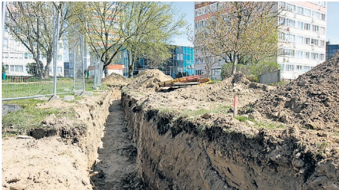
Budowa sieci ciepłowniczej w rejonie ulic Bydgoskiej i Dworcowej
