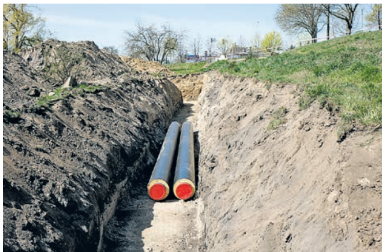
Budowa sieci ciepłowniczej w rejonie ulic Bydgoskiej i Dworcowej
