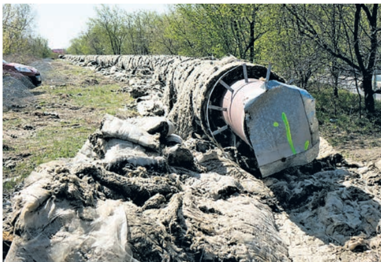
MPEC likwiduje znaczne odcinki napowietrznej sieci ciepłowniczej. Na zdjęciu – ulica Świętojańska
