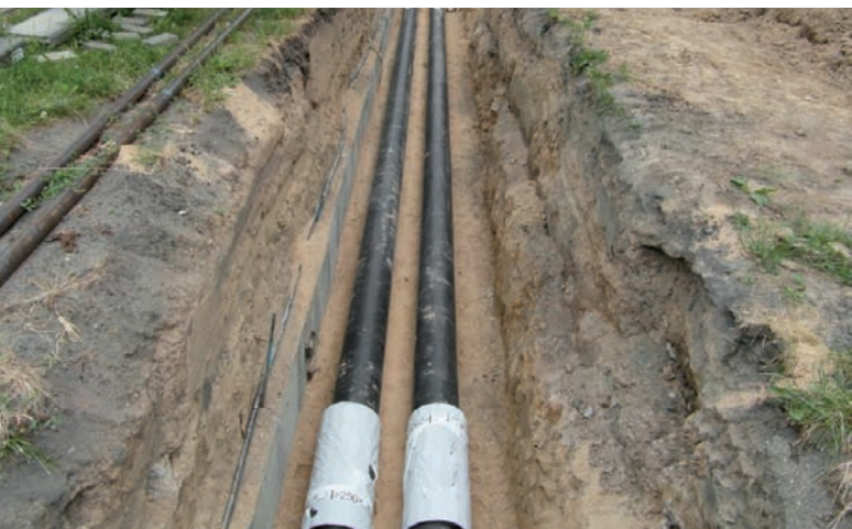
Wymiana sieci w ul. Kolejowej
