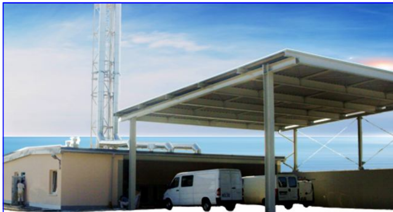
Kotłownia dla osiedla Cukrownia Goślawice
