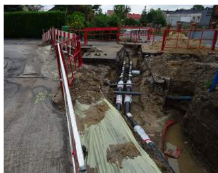
W rejonie ul. Kolskiej i Reformackiej trzeba było pokonać wiele trudności związanych z ominięciem innych sieci
