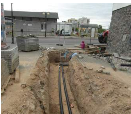
MPEC wykonało nowe przyłącze ciepłownicze do Wieży Ciśnień przy ul. Kolejowej
