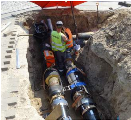
W ul. Tadeusza Kościuszki istniejącą sieć ciepłowniczą zastąpiono siecią o większej średnicy
