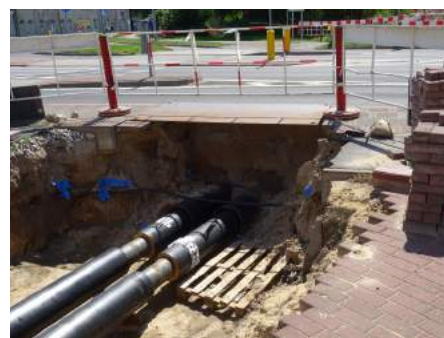
Metodę przewiertów sterowanych przy układaniu sieci ciepłowniczej zastosowano również w okolicach ronda Kamińskiego
