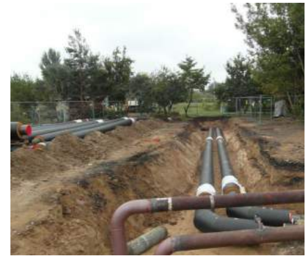
W ramach budowy łącznika ul. Wyzwolenia z ul. Paderewskiego, zaistniała konieczność likwidacji sieci ciepłowniczej nad torowiskiem i ułożenie jej jako podziemnej pod torami kolejowymi
