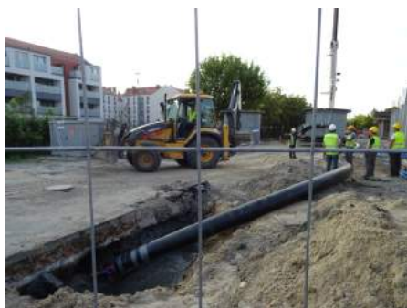
Przejście pod ul. Szarych Szeregów wykonano techniką kabla ciepłowniczego FHK 200/310
