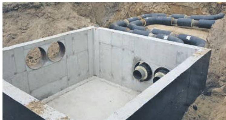
W pobliżu Sądu Okręgowego w Koninie powstaje podziemna komora ciepłownicza, w której zbiegną się trzy odcinki sieci
