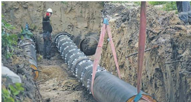
W związku z przebudową sieci ciepłowniczej wykonano przewiert pod Trasą Warszawską
