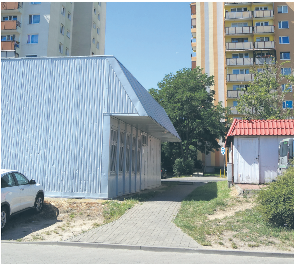
Stary węzeł grupowy umiejscowiony w odrębnym budynku
