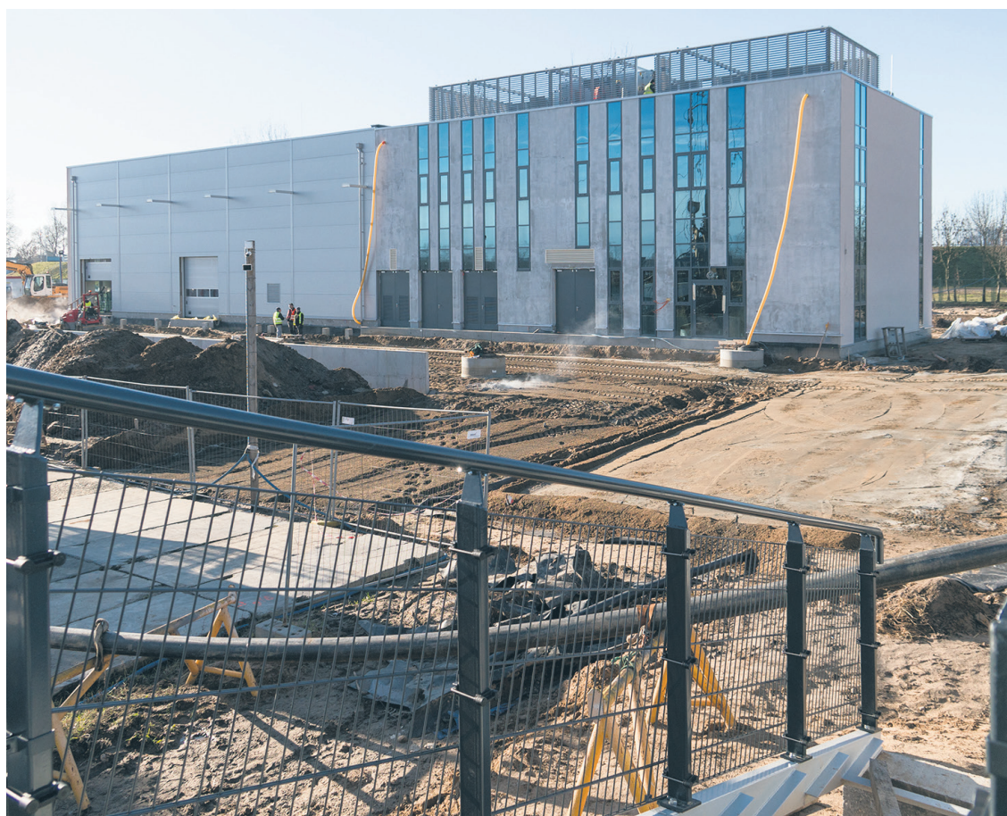
Budowa infrastruktury napowierzchniowej jest już na bardzo zaawansowanym etapie
