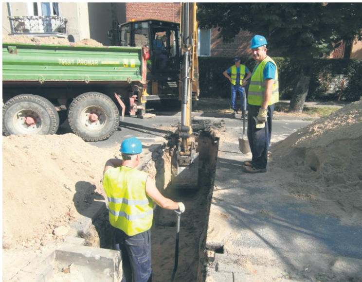
Nowe przyłącze na ul. Mickiewicza
