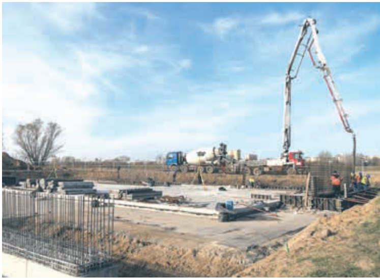
Budowany jest żelbetowy pomocniczy zbiornik o pojemności około 2.000 metrów sześciennych
