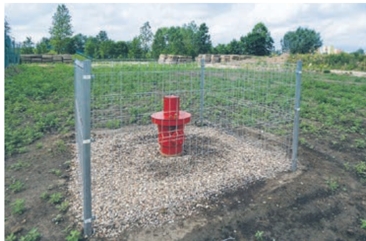
Zabezpieczony odwiert GT-1
